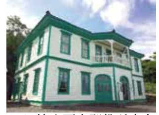
4 旧檜山爾志郡役所庁舎
