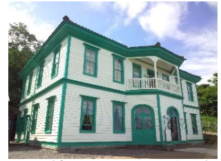
4 旧檜山爾志郡役所庁舎
