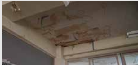
江差小学校教室の雨漏り改修
