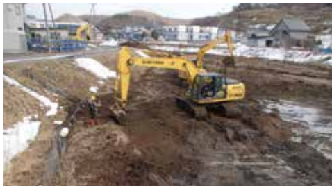
土砂撤去が進められている田沢川
