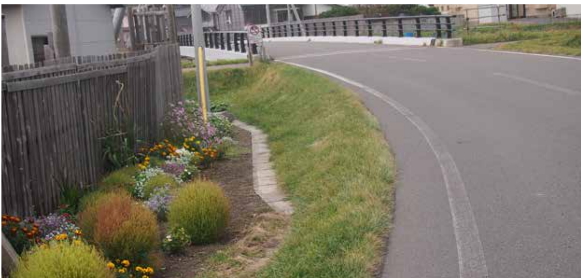
車道より低区となっているために雨水が流入
