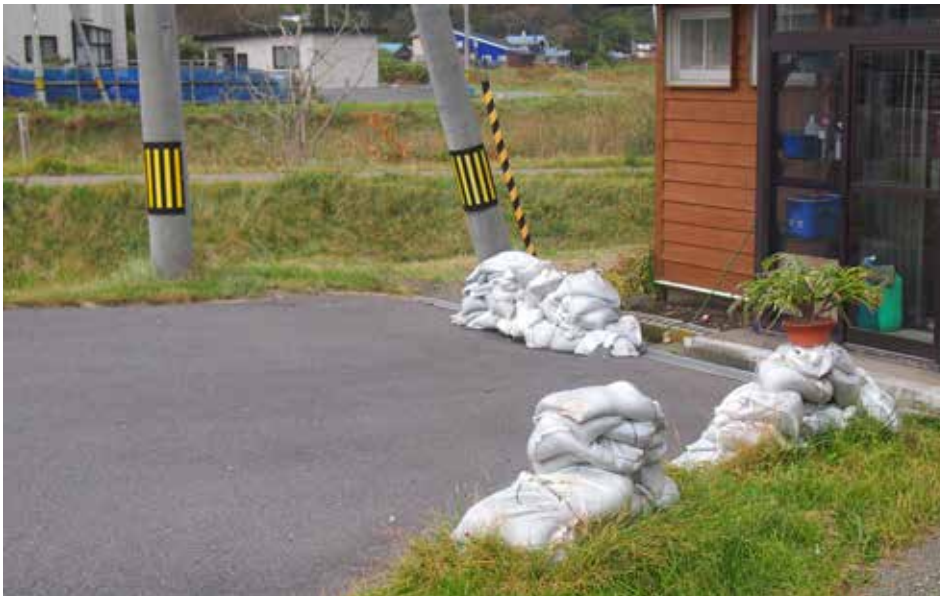
降雨対策のため、玄関前に土嚢積み
