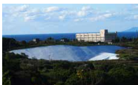
延命化が必要な最終処分場
