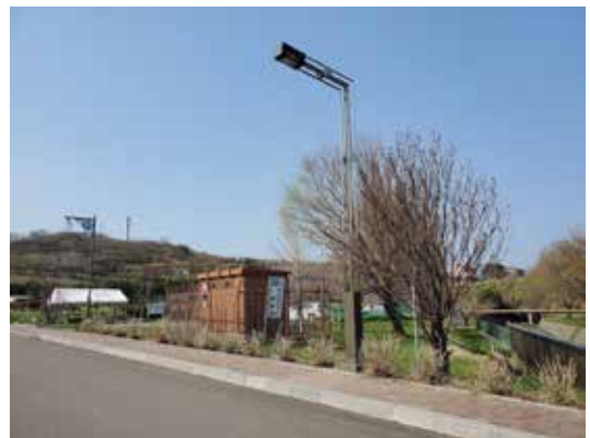
LED化に改修される運動公園街路灯
