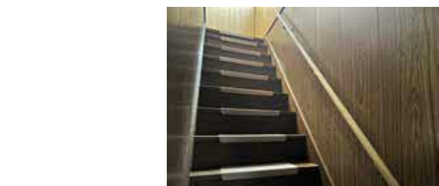
転倒防止手すりの設置
