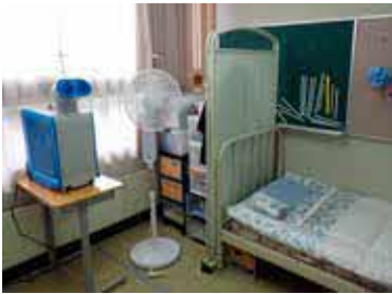
小学校保健室設置のスポットクーラー
