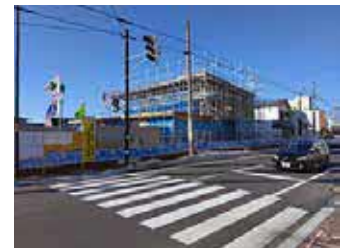
現在のコミュニティプラザえさし建設工事の様子
