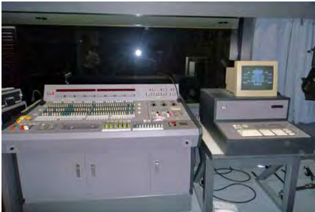
現在の文化会館の調光設備
