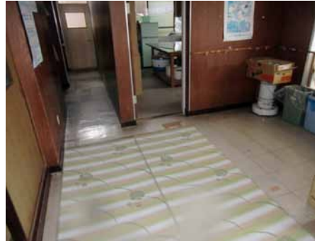
朝日児童館は昭和48年建築。平成18年には外壁や屋根の改修を行っている。
