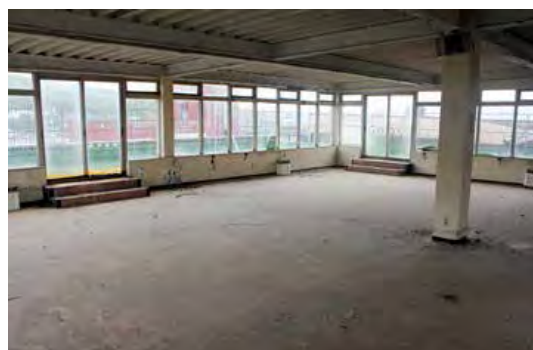
現在の江光ビル内部(6階プレイルンド)
