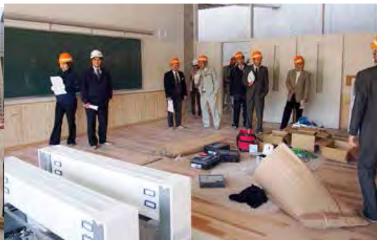
(右) 新江差中学校の教室を見学 (左) 工事関係者から施設の詳細、工事の概要について説明を受ける。
