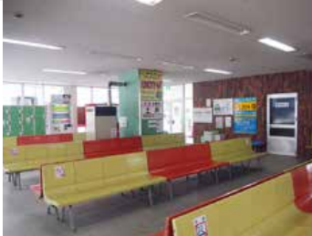
(上) フェリー乗り場（港湾センター）外観 (下) フェリー乗り場内の待合所。建物全体が老朽化し、改修が必要な状況となっている。
