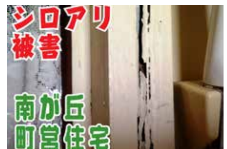
議員が本会議場で使用したパネル写真。南が丘町営住宅のシロアリ被害。
