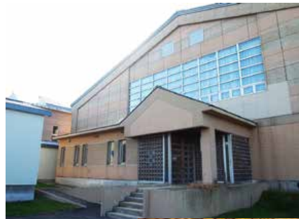
江差北中学校体育館。雨漏りの他に風の強い日は風の音がひどく、授業等に支障をきたしている。外壁が脱落している部分もあり早急な対応が必要。
