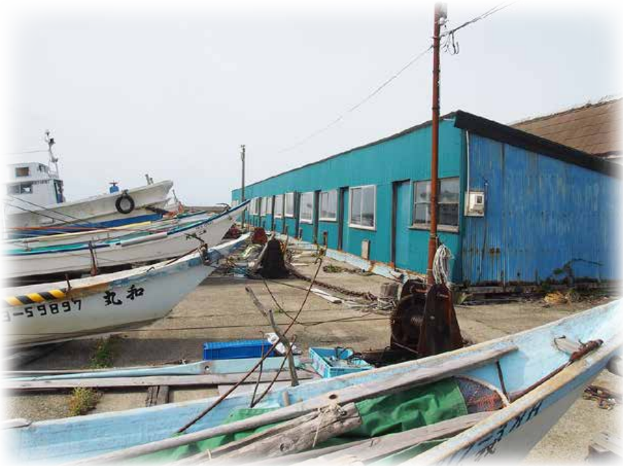
津花漁港の機械庫
