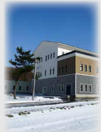
下水道管理センター
