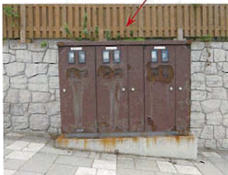
【塩害等により腐食が進行し、倒壊の危険のある分電盤】
