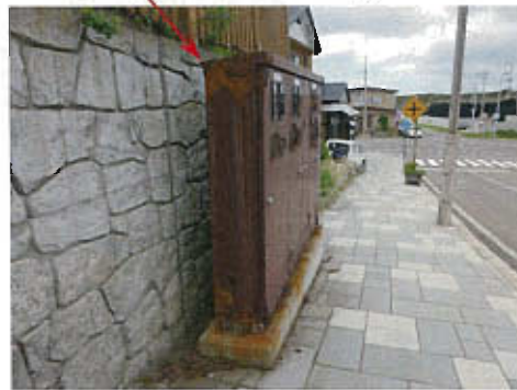
【塩害等により腐食が進行し、倒壊の危険のある分電盤】
