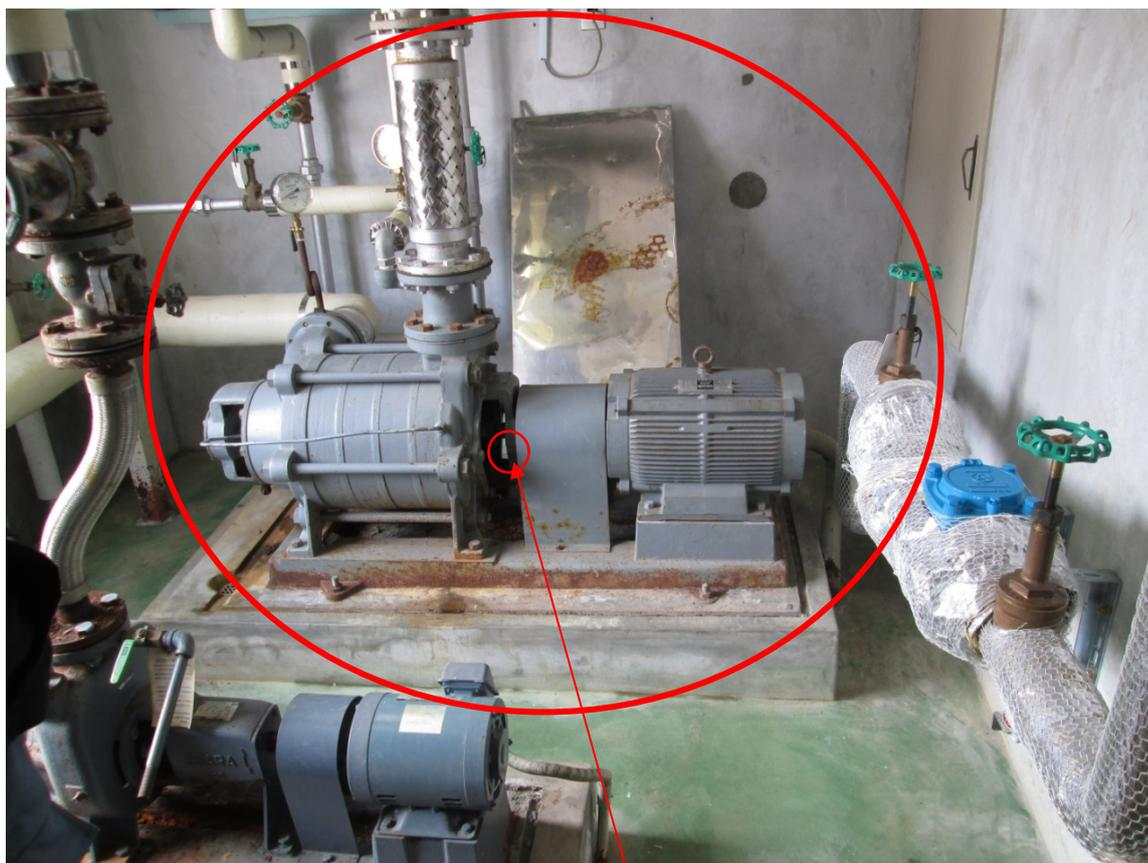
調査結果：経年劣化によりポンプ内部が固着している可能性があり、ポンプ回転不能
