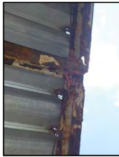
損傷箇所拡大写真
