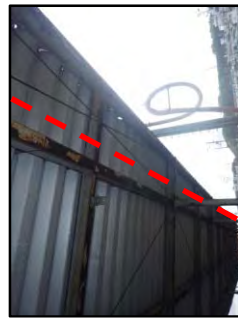
【江差港船澗上屋の状況】(赤破線が切断箇所)
