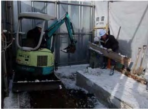
【工事着手状況】
