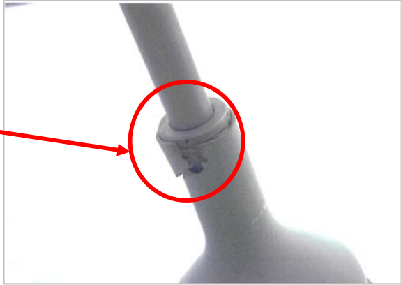
赤丸部分：中央増幅器カバーに亀裂・変形
