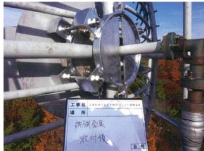
亀裂部を特注金具で仮固定
