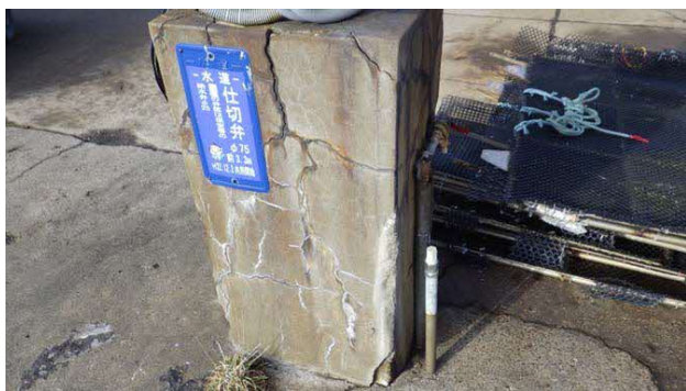
水道設備等の撤去
