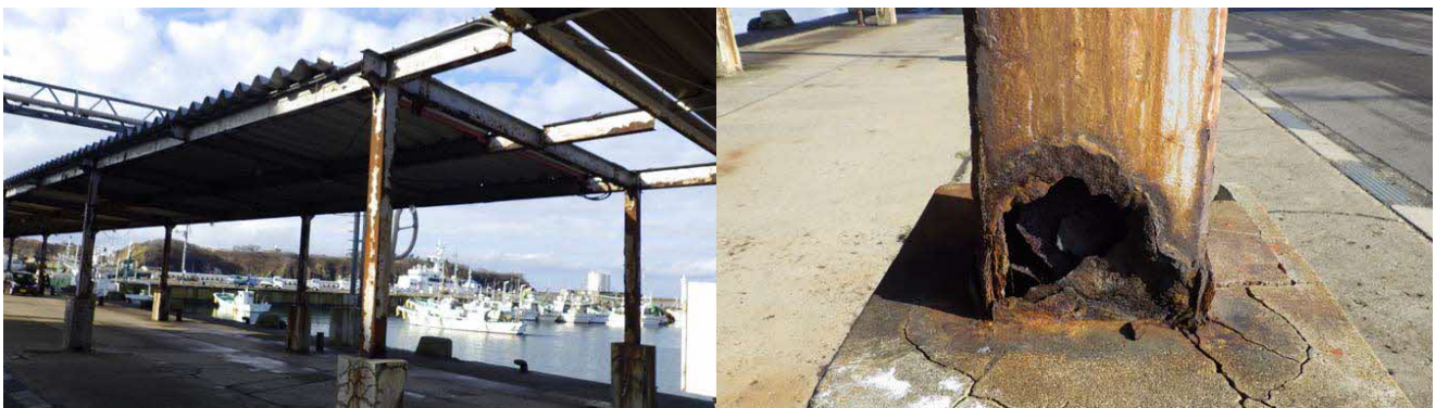
江差港水産物荷捌上屋の状況
