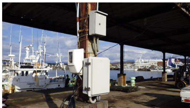
電気設備を一度移設
