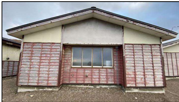
西側外壁・破風板現状
