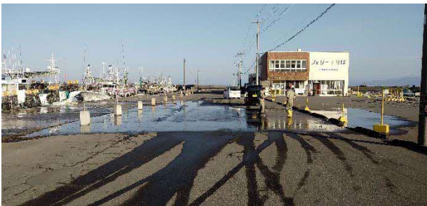
漏水時の現場周辺の状況
