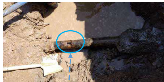
老朽化が進んでいる給水管 (○は今回破損箇所)
