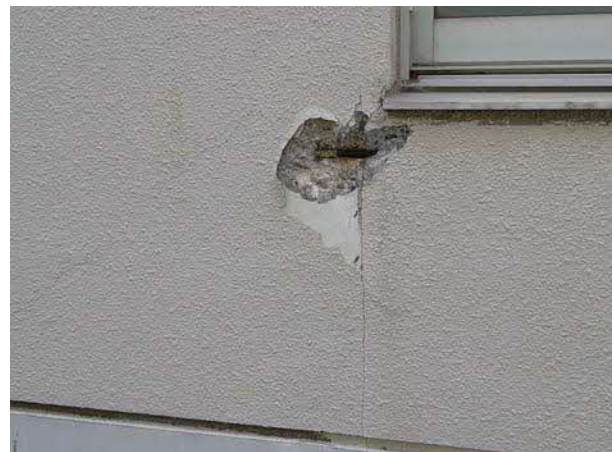
クラック 113か所（概数）、コンクリート爆裂 19か所（概数）
