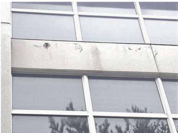
クラック 113か所（概数）、コンクリート爆裂 19か所（概数）
