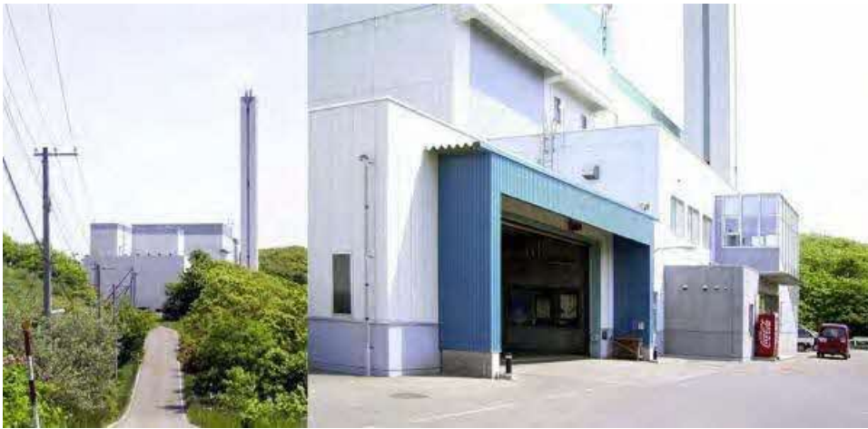
南部桧山清掃センター
