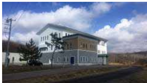
下水道管理センター
