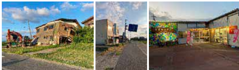
【倒れている家屋(左)・傾いている道路看板(中)・道の駅すずキッチン(右)】
