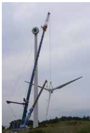
羽の解体作業中の写真
