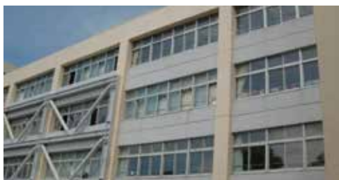
↑現在の江差小学校の外観。窓を全開に換気を行っています。網戸の設置により虫の侵入を防ぎ、安心した室内換気へ環境整備を行います。
