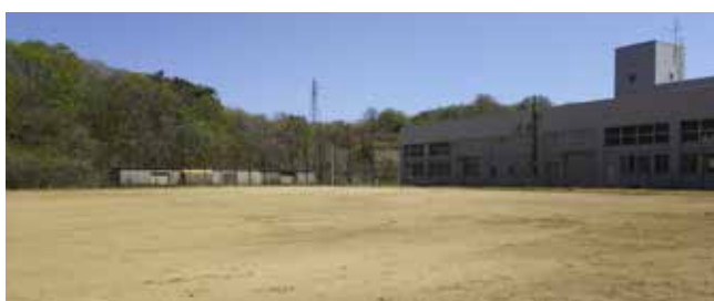
▲綺麗に整地されたグラウンド。新たな運動競技場として様々な屋外スポーツで利用できる
