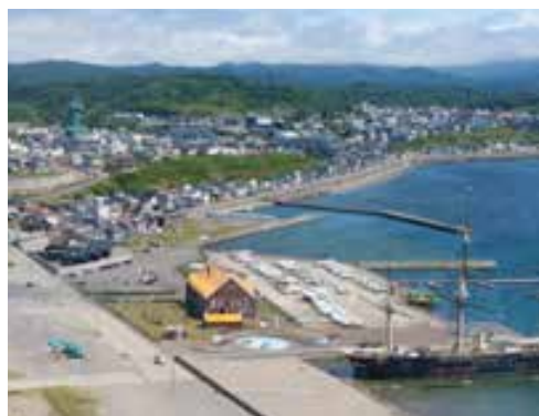
▲道の駅の建設を計画している開陽丸管理棟エリア
