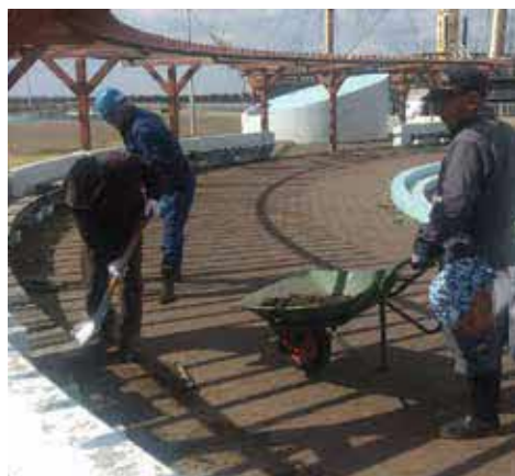
▲広場に溜まった砂の除去作業のようす
