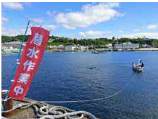
防波堤からの調査風景
