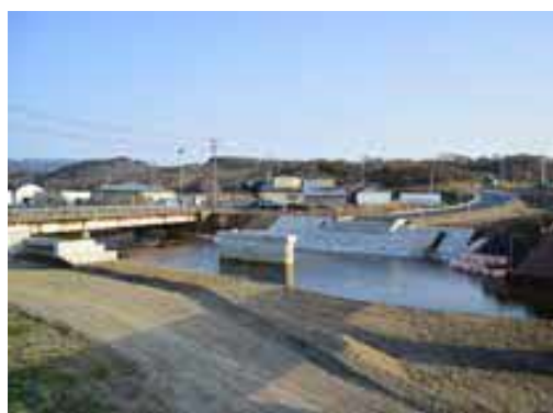
第3 榎川橋架換工事は令和3年度に着手し、 令和6年度を完成予定としている
