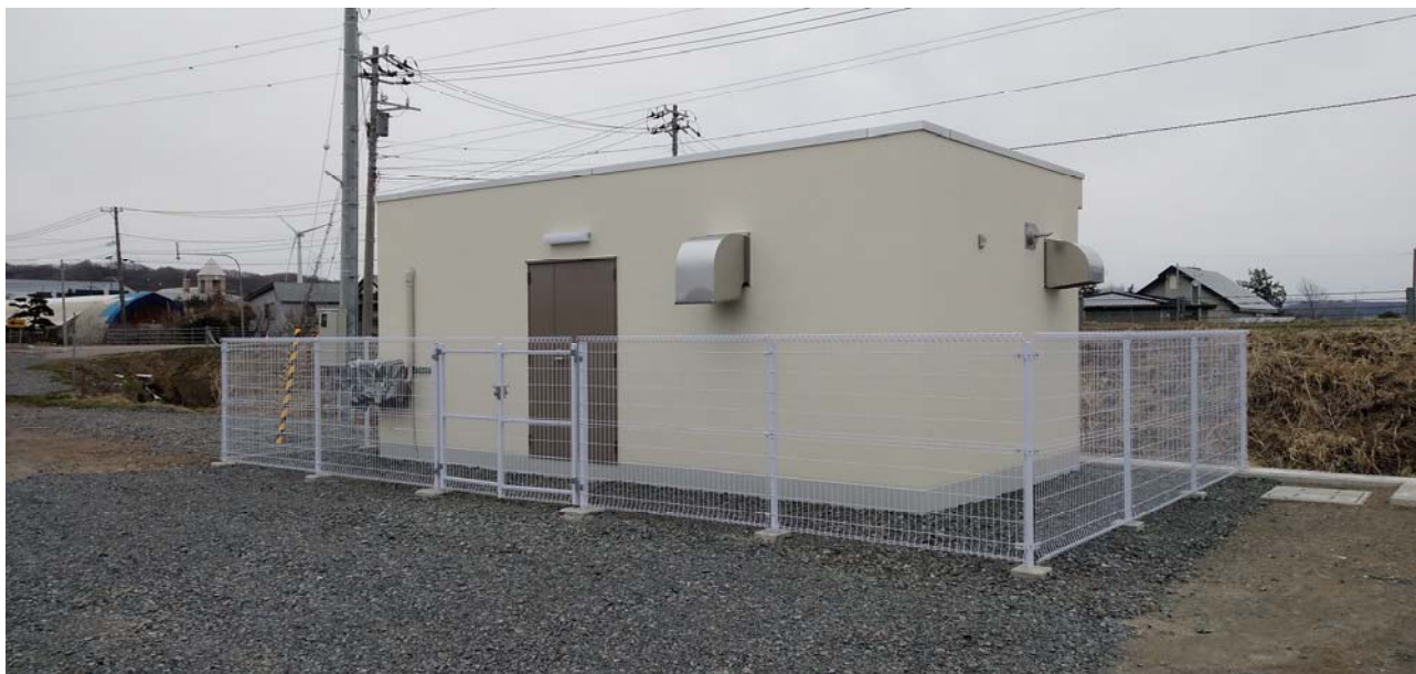
水堀流量計室
