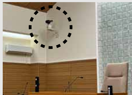
故障中のカメラを含む映像設備を更新する
