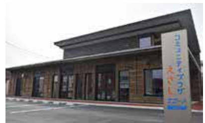
コミュニティプラザえさし外観
