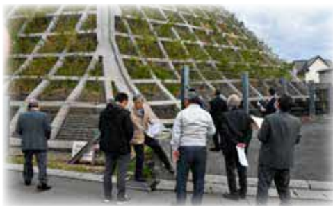
陣屋円山地区町有地法面崩落防止工事視察
