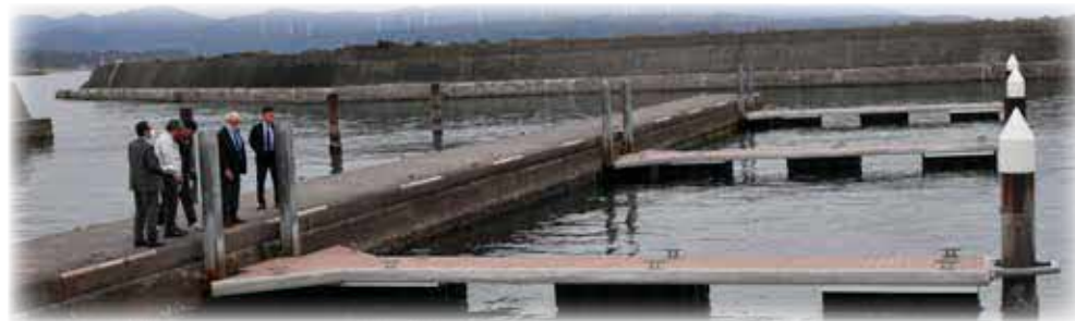
江差港マリーナ修繕（浮桟橋ガイドローラー修繕他）視察
