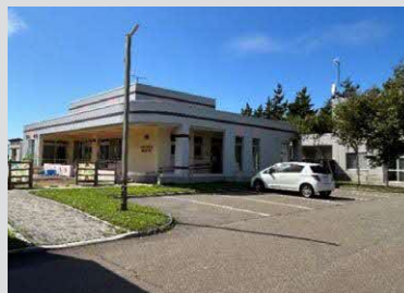
道立江差病院内保育所外観
