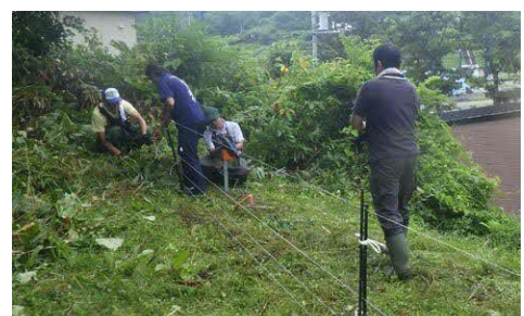
電気柵設置の様子 ※3
