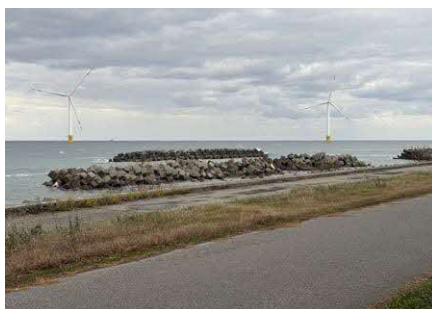
現地での洋上風力発電所（風車の様子）
