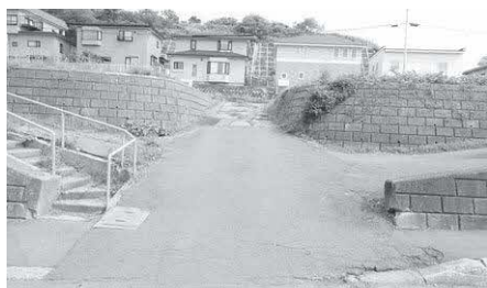
未利用町有地となっている旧円山第3団地跡地
