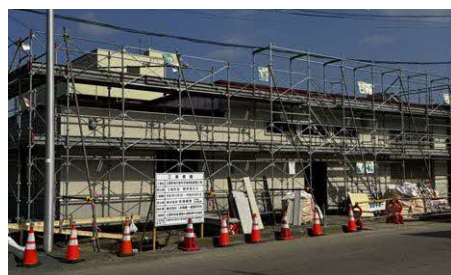
新築工事中の市場
