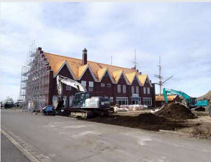
解体中の開陽丸青少年センター
