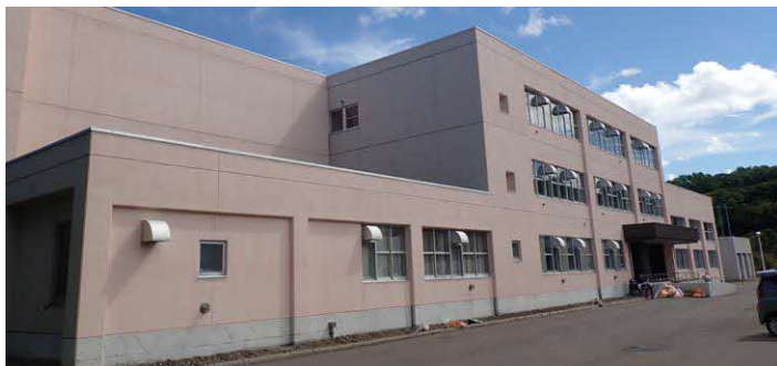
洋上風力人材育成施設として活用が予定されている「まなびつく」
