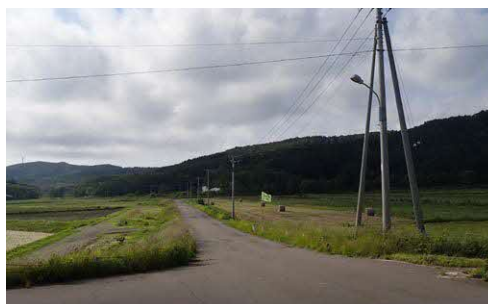
道路改良工事予定の「五厘沢山崎線」
