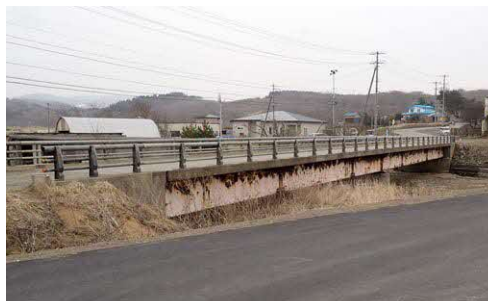
解体予定の「旧第3楸川橋」
