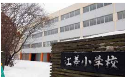
改修整備が望まれる江差小学校
