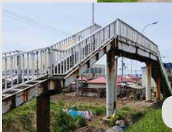
南ヶ丘歩道橋 (解体撤去)
