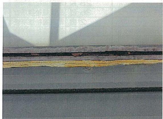
④署事務所の外部状況、窓枠の腐食が進み、防水コーキングも劣化している
