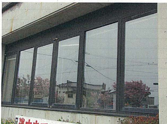
④署事務所の外部状況、窓枠の腐食が進み、防水コーキングも劣化している
