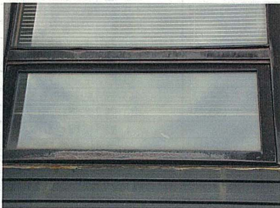
①消防団室開閉窓の外部の状況、腐食により窓枠は湾曲に歪み開閉不能防水コーキングが浮き上がり隙間ができている(②研修室・③集会室も同様)
