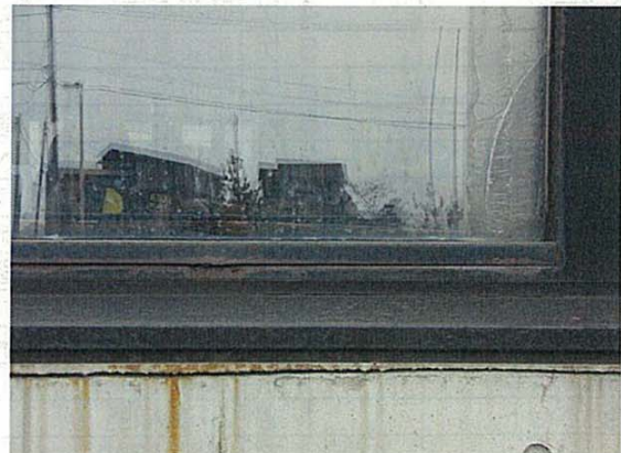
①消防団室開閉窓の外部の状況、腐食により窓枠は湾曲に歪み開閉不能防水コーキングが浮き上がり隙間ができている(②研修室・③集会室も同様)
