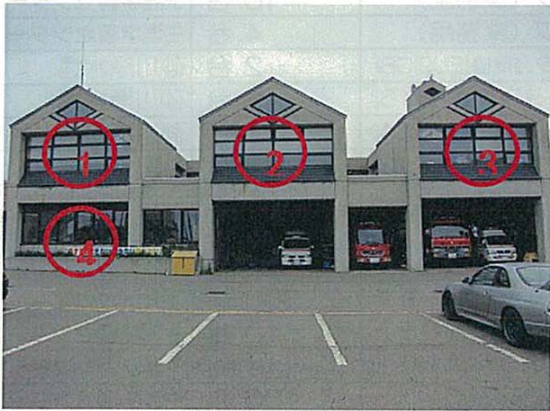
消防庁舎全景 ①消防団室②研修室③集会室④署事務室
