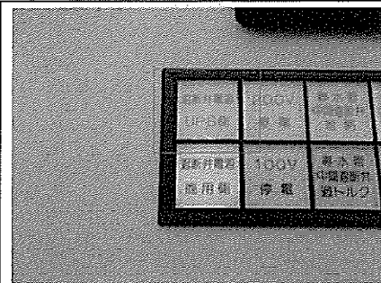
D 北村緊急遮断弁室
