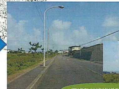
適切な維持修繕を実施
