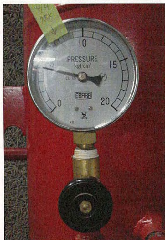
配管内に水を止めておく圧力を示すゲージ。 圧力が自然に下がることで劣化が判明
