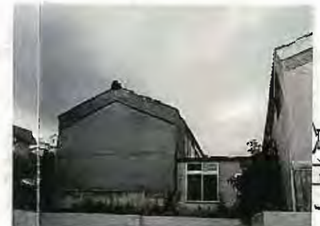
土蔵②外観(国道から)
