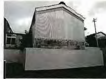
土蔵④外観(国道から)
