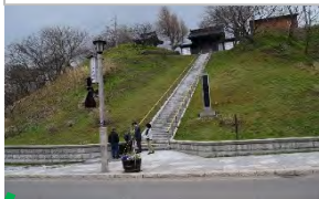
既存、湧水設置個所 (東別院)
