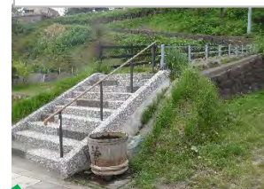
既存、湧水設置個所 (横山家向い)
