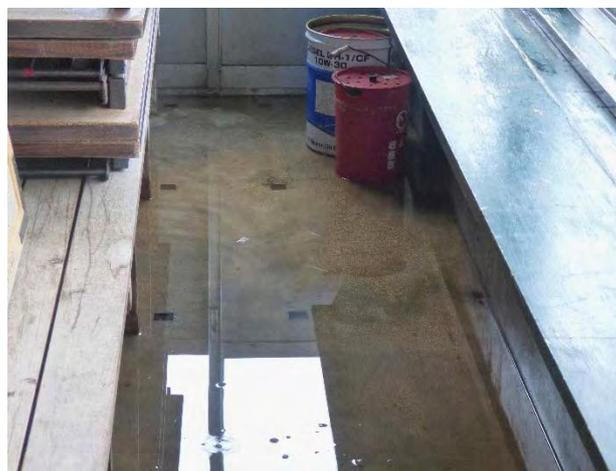
管理棟内部の雨漏りの状況写真
